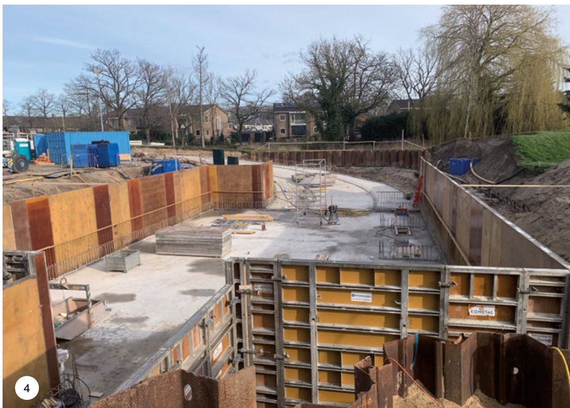
De aanleg van de toegangsweg naar de ondergrondse garage. Gezien vanaf het huis. Foto Piet Gentenaar.
