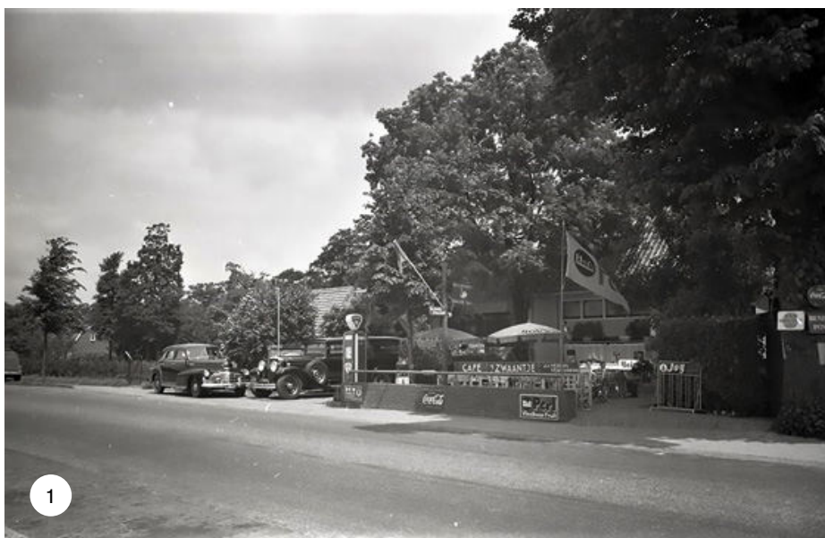
Uitspanning 't Zwaantje aan de Straatweg/hoek Bolensteinseweg (1950). Op die plek is nu restaurant August gevestigd. Archief HKM.
