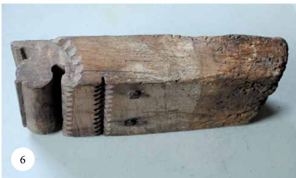
Voorbeeld van een gotisch sleutelstuk met peerkraalprofielering. Dient ter ondersteuning van een draagbalk. Collectie en foto Jaap Kottman.
