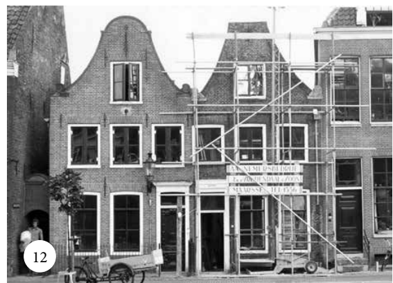
Foto van de verbouwing van Schippersgracht nummer 9 in 1979. Collectie Rijksarchief Utrecht.
