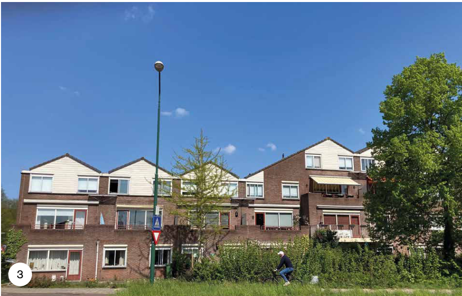
Appartementengebouw op de plek van de Ds. Sandersschool aan de Straatweg/Gaslaan. Foto Jan Simonis.
