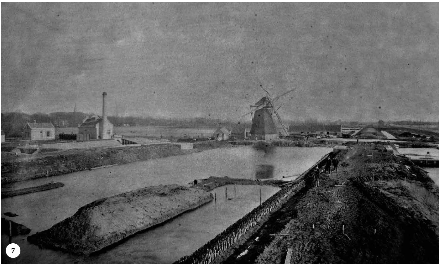
De laatste aanblik van de Maarssebroekse watermolen. Zowel het links staande stoomgemaal als het oprukkende Merwedekanaal geven aan dat zijn laatste uren hebben geslagen. Bron: onbekende fotograaf omstreeks 1890.
